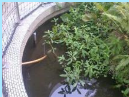
利用水管接收雨水 引入水生植物池
