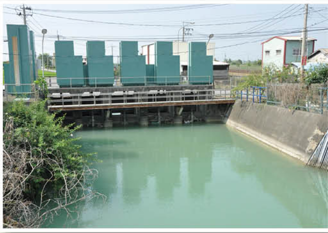
▲嘉南大圳閘門
