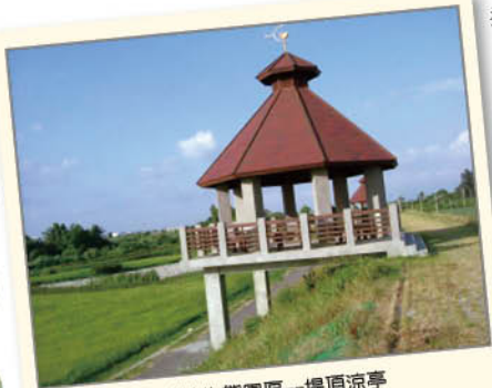
灘地生態園區—堤頂涼亭
