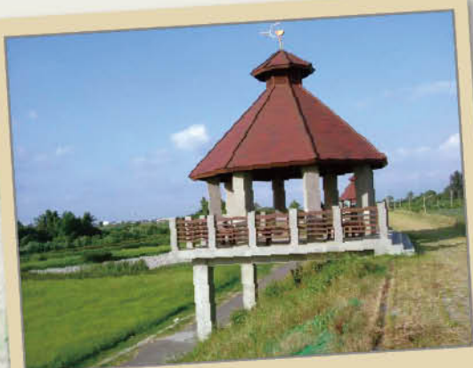
灘地生態園區—堤頂涼亭
