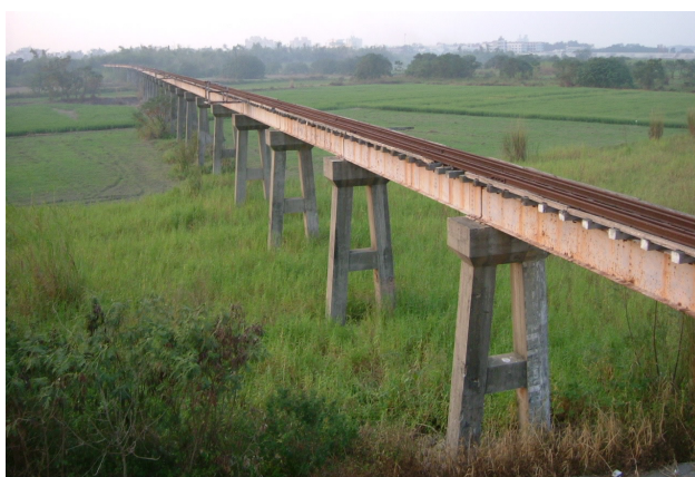
圖 13 台糖北港溪鐵橋
