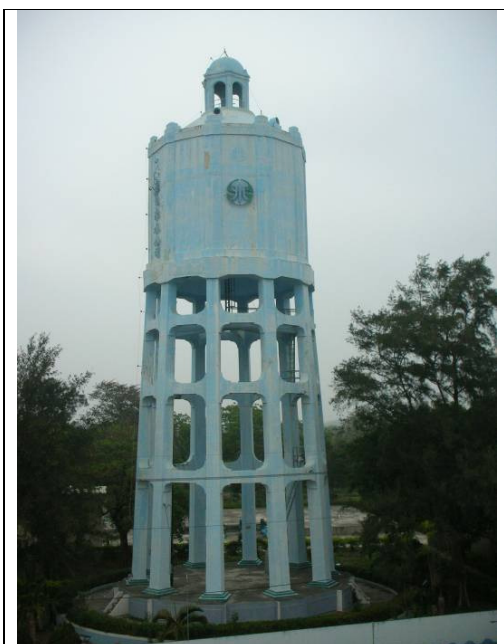
※圖 1-11 朴子市地標-自來水塔
