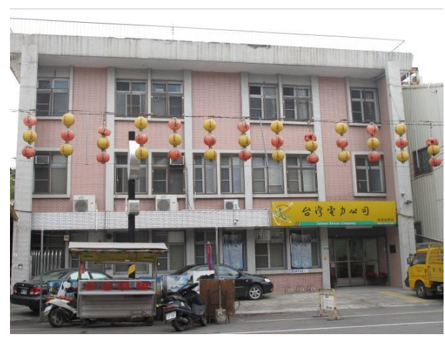
台電新港服務所
